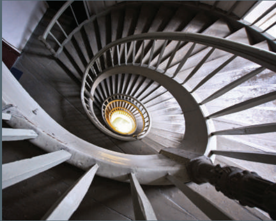
Ihanteellinen hissittömissä rakennuksissa, esim. vanhoissa kerrostaloissa.
