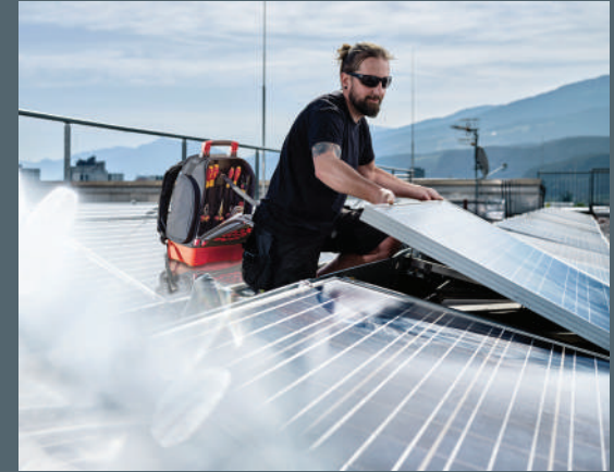
Käytännöllinen kattotöissä, esim. asennettaessa aurinkokennoja.
