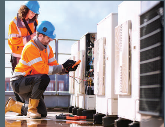
Ilmastointitekniiikan asennus- ja huoltotyöt katolla.
